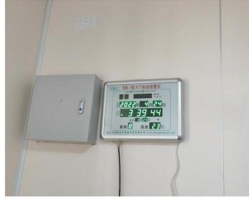
固定式 SB-1 型 x/γ射线报警仪
